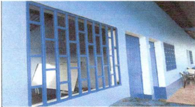
Foto 1: sustitucion de balcones
