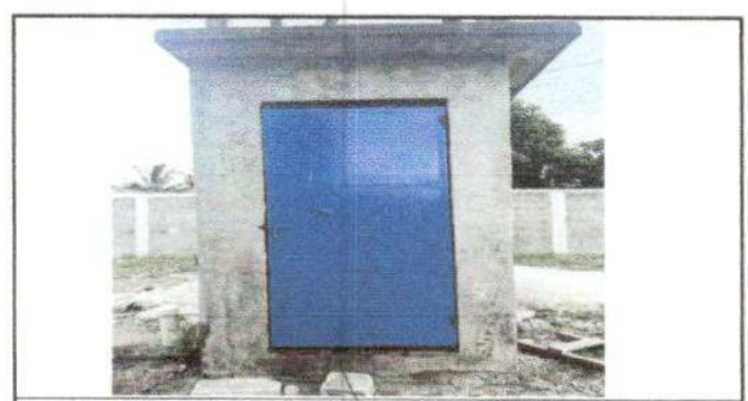
Foto 6: sustitucion de puerta de metal
